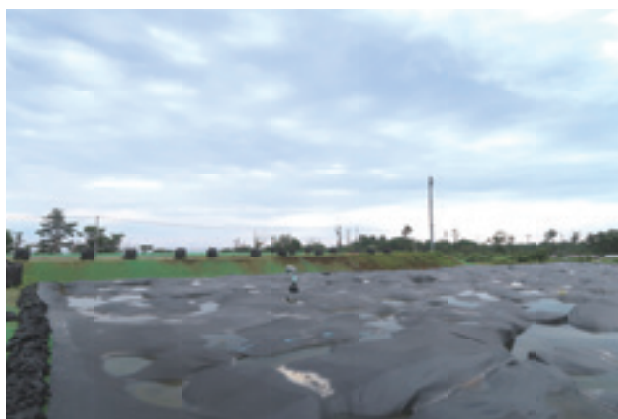
図3 仮置場の現状 (土盛り、ゴムラバーで覆われたフレコンバッグ)
